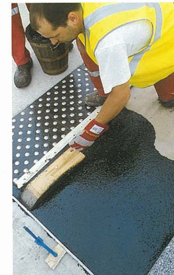
Mise en œuvre de l'asphalte de revêtement
