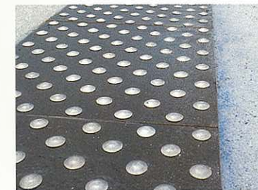
Positionnement des dalles
