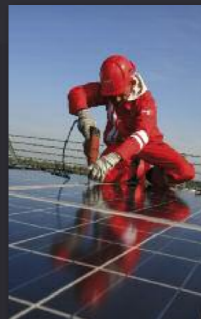
Pose de SURFA® 5 SOLAR
